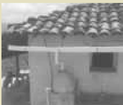
Canaletas y filtro en sistema doméstico de cosecha de agua, en Sri Lanka // Fuente: Practical Action
