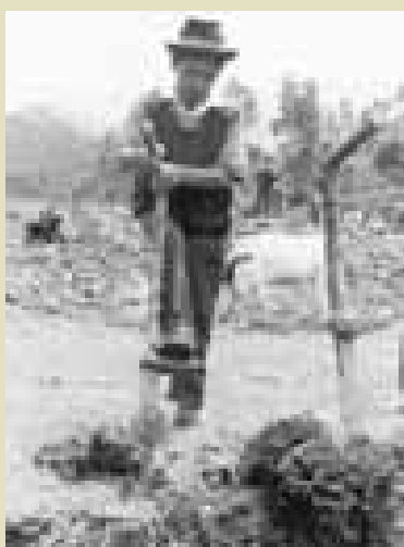
Volteo de la tierra
