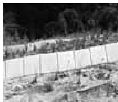
Uso de vetiver para taludes empinados y canales de drenaje // Fuente: DOMUS S.A.C.
