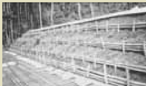
Estaquillados de bambú en la plataforma Fuente: DOMUS Consultoría Ambiental S.A.C.
