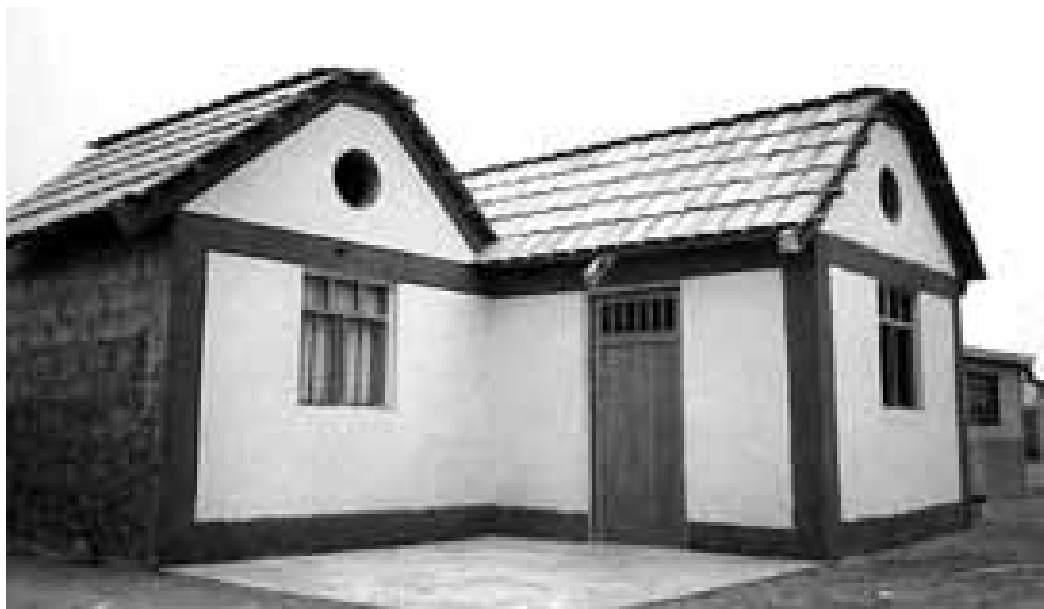
Vivienda de adobe reforzado construida por Soluciones Prácticas en Tacna.
