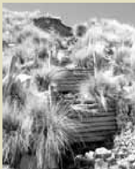
Diques de madera como disipadores para controlar los flujos de agua y lodo en una quebrada estacional Fuente: Georg Heim
