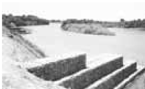
Dique con espigón transversal 73 en el río Tumbes (Perú) Fuente: PERPEC
