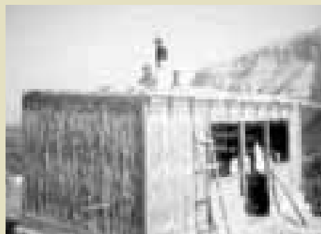
Módulo de quincha mejorada en construcción Fuente: Predes
