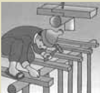
Construcción de cobertizo Fuente: Predes
