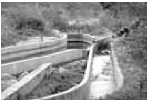
Cauces de alivio en Piura, Perú Fuente: Víctor Ventocilla, 2006
