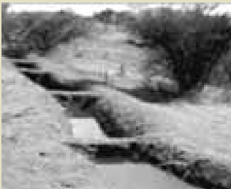
Tabiques en una zanja de infiltración Fuente: Guerrero
