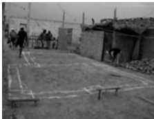
Colocación de balizas y trazado de cimientos, listo para excavar
