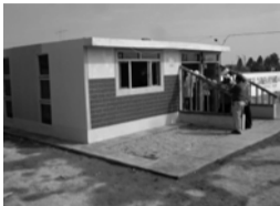
Local construido con quincha mejorada
