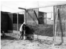
Revoque de muros enquinchados con barro con paja
