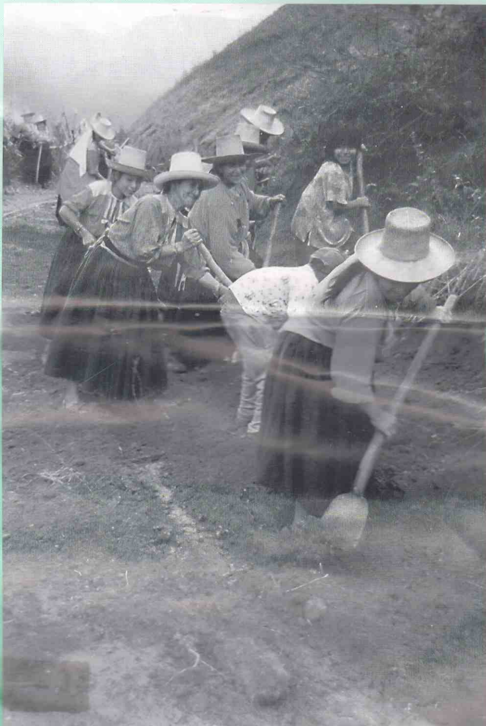
Foto IIDIG: Apertura de canal de conducción. MCH Kañaris, Lambayeque, Perú.
