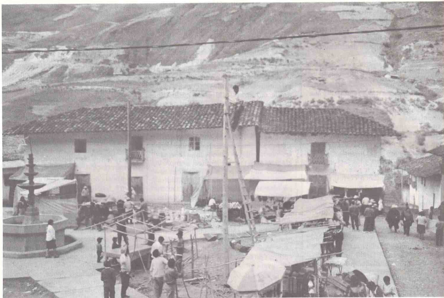
Foto: Archivo ITDG-Perú. Instalación de la red secundaria.
