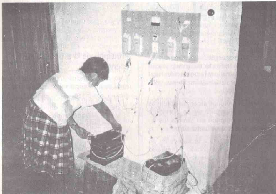
Foto: Archivo ITDG-Perú. Cargador de baterías accionado por molino de piedras mejorado.
