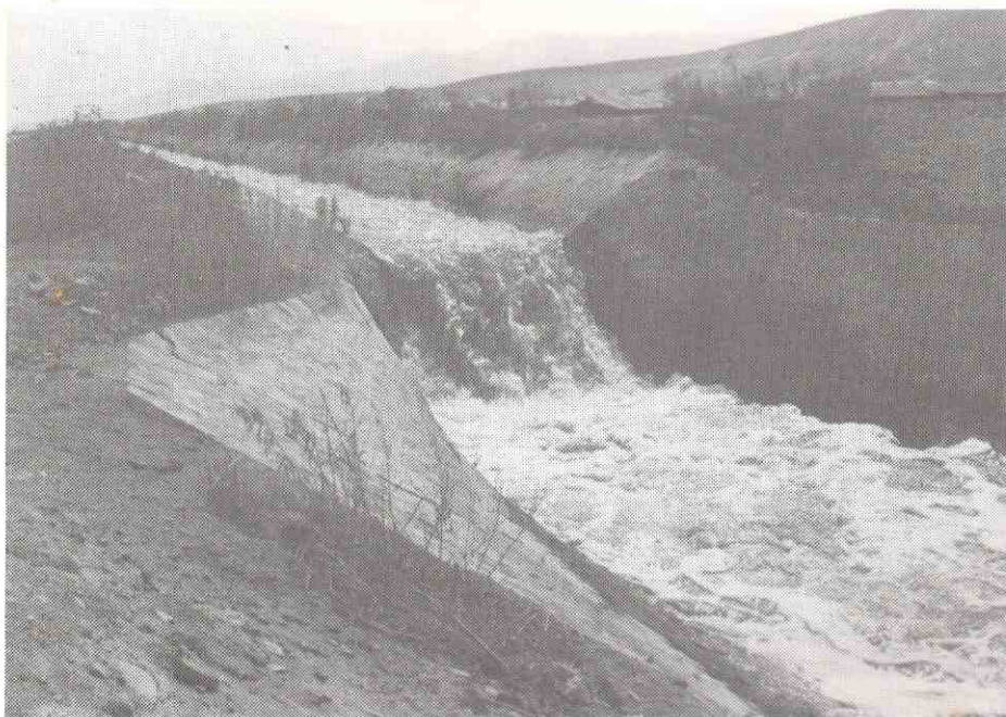
Fig. 4: Una caída de 2.2 m. de un canal de irrigación con un potencial de 40 kW de potencia. La Joya, Perú.
