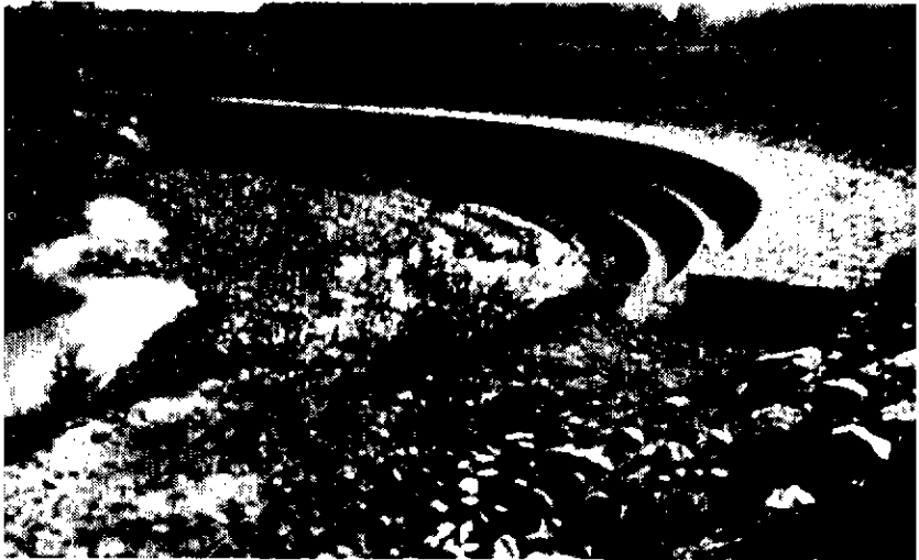
Canalización de un torrente en su curso inferior dando protección a la zona cóncava del cauce.
